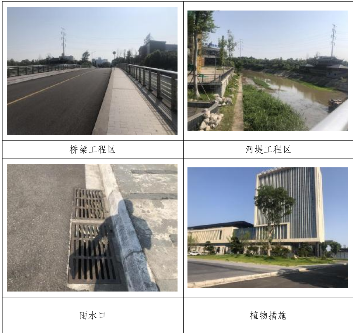
图 3 现场调查图片
